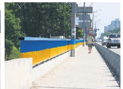
Міст на житомирську трасу біля автостанції «Дачна»
